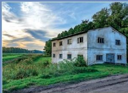
Stawy Zawada Teiche in Zawada
