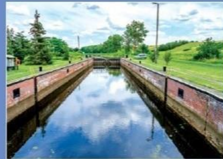
Śluza na Noteci Schleuse an der Netze
